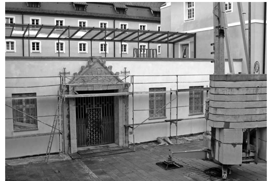
Baustelle Alte Pforte
