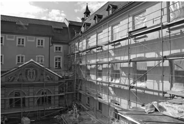
Fassadensanierungsarbeiten im Josefgarten
